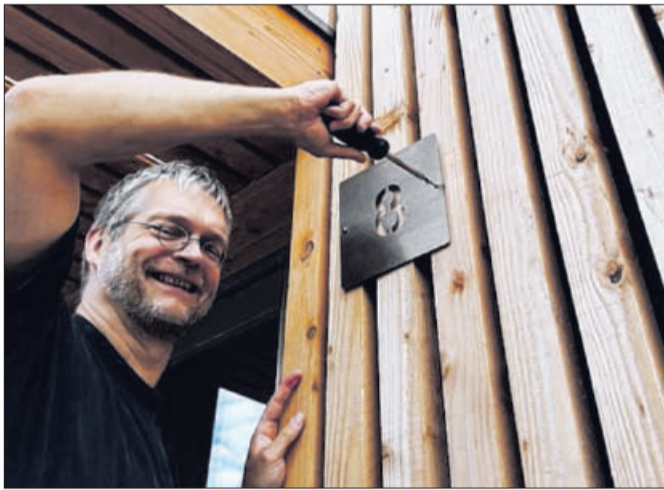
Bauherr Andreas Fischer-Klärle beim Anbringen der Hausnummer.
